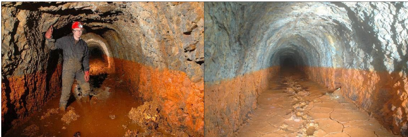
Stav štoly z roku 2013.
