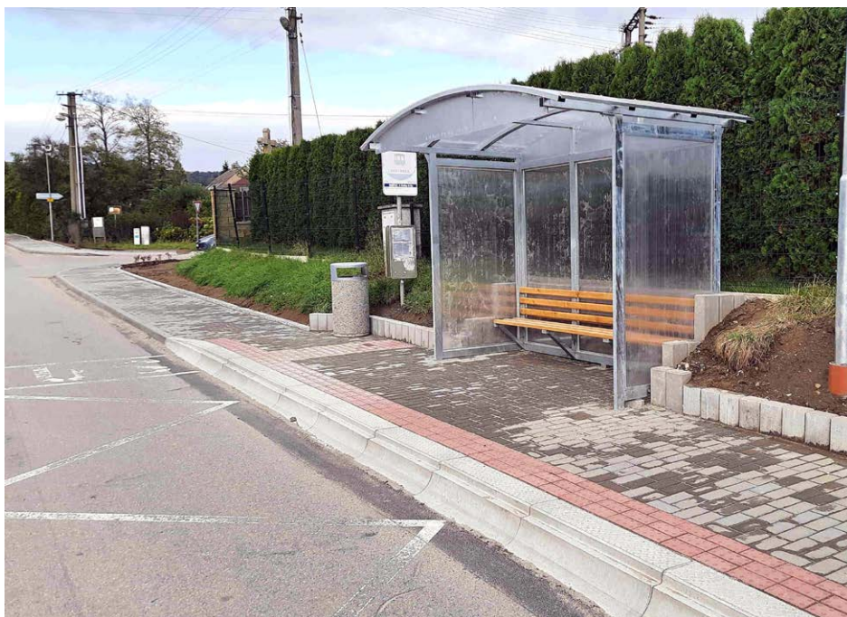
Chodník Brněnská ul., celkové náklady 3,598 mil. Kč, dotace 3,418 mil. Kč – 95 %
