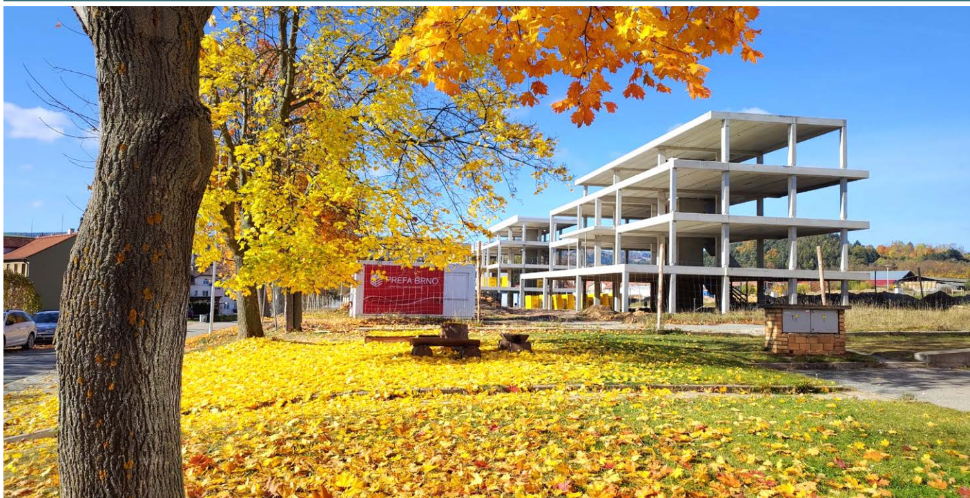
Výstavba tří nových bytových domů v Nové ulici
