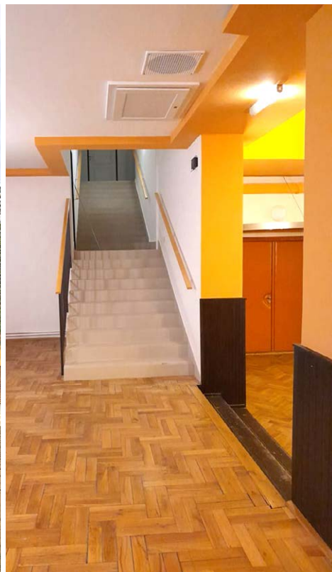
Rekonstrukce kulturního domu, celkové náklady 2,572 mil. Kč, dotace 1,739 mil. Kč – 68 %
