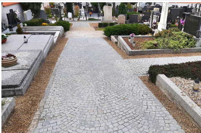
Chodníky v nové části hřbitova, celkové náklady 355 tisíc Kč
