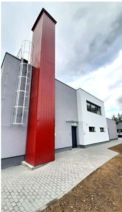
Novostavba hasičské zbrojnice, celkové náklady 16,686 mil. Kč, dotace 7,5 mil. Kč – 45 %
